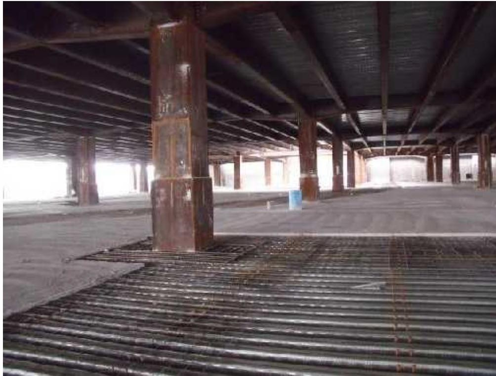
Acero por temperatura en deck metálico
