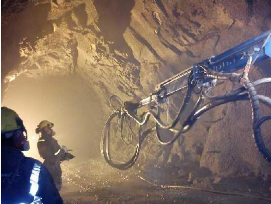
Concreto lanzado en túneles (shotcrete)
